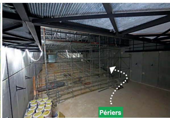
Travaux en cours de requalification du cinéma en salle multiculturelle (CPS)
