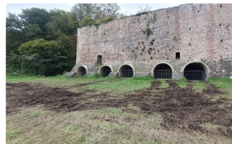
Aménagement des fours du Hamel Bazire (2024)
