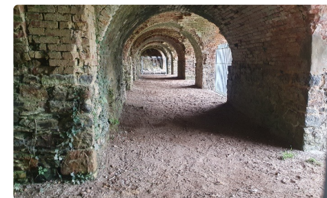
Aménagement de la première travée des fours du Hamel Bazire (2024)
