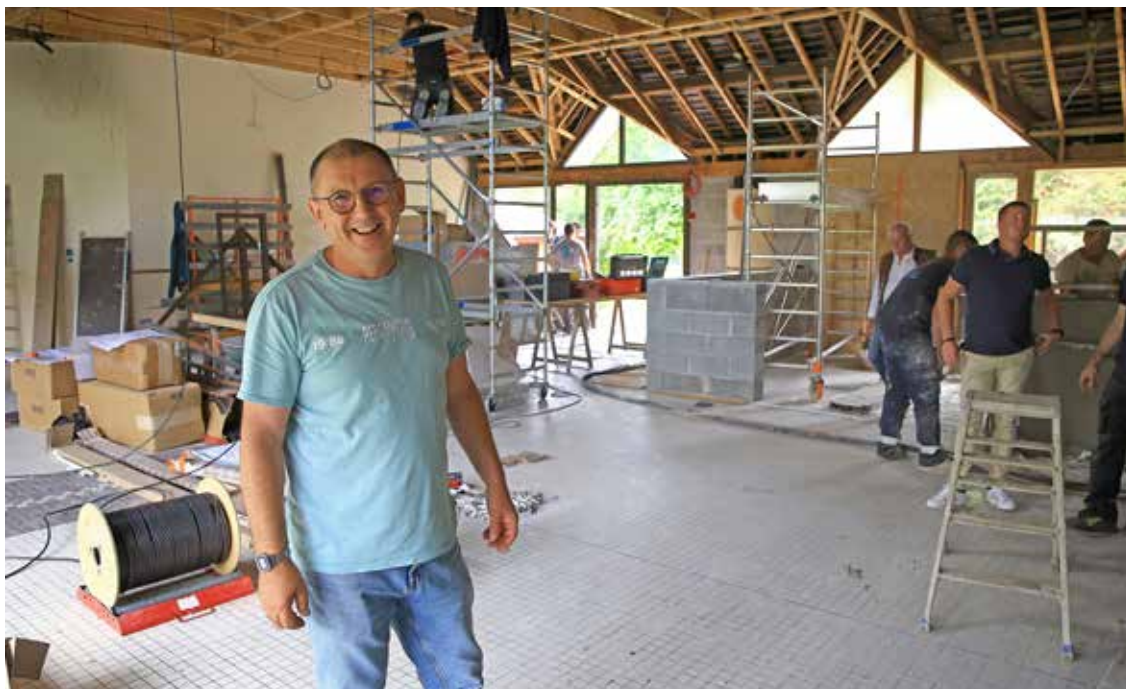
Yann Le Bot, ingénieur au Département, a suivi de près le chantier du collège Le Moulin de Haut, à Percy- en-Normandie
