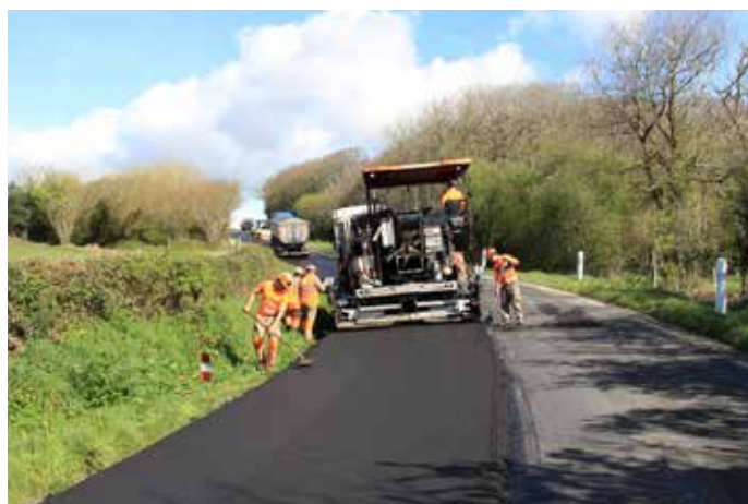
Une première dans la Manche : les enrobés à froid © P. Lhullier
