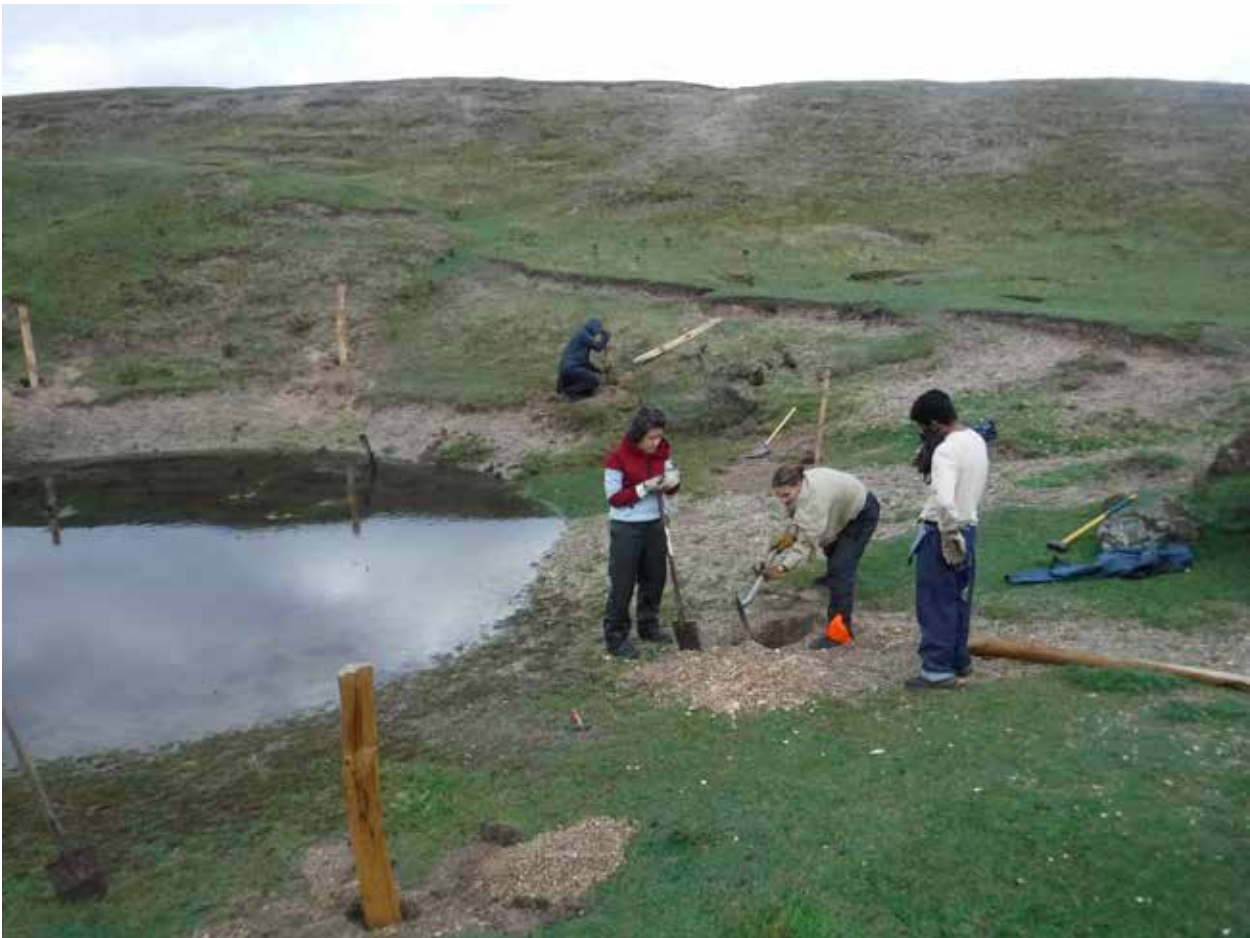
Chantier de clôture d'exclos autour d'une mare sur la Pointe d'Agon - © DR
