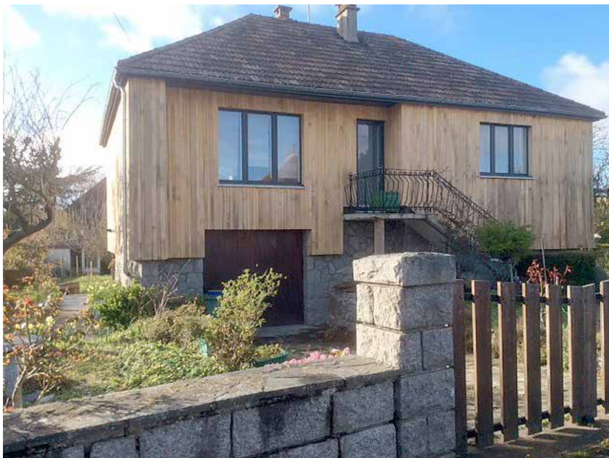
Exemple d'isolation par l'extérieur, réalisée en fibre de bois et recouverte d'un bardage en châtaignier d'origine locale, à Donville-les-Bains - © Céline Hervé
