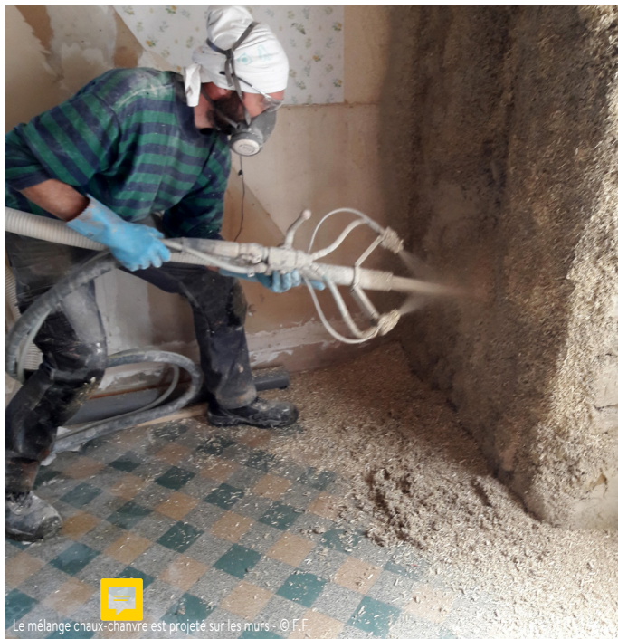
Le mélange chaux-chanvre est projeté sur les murs - © F.F.
