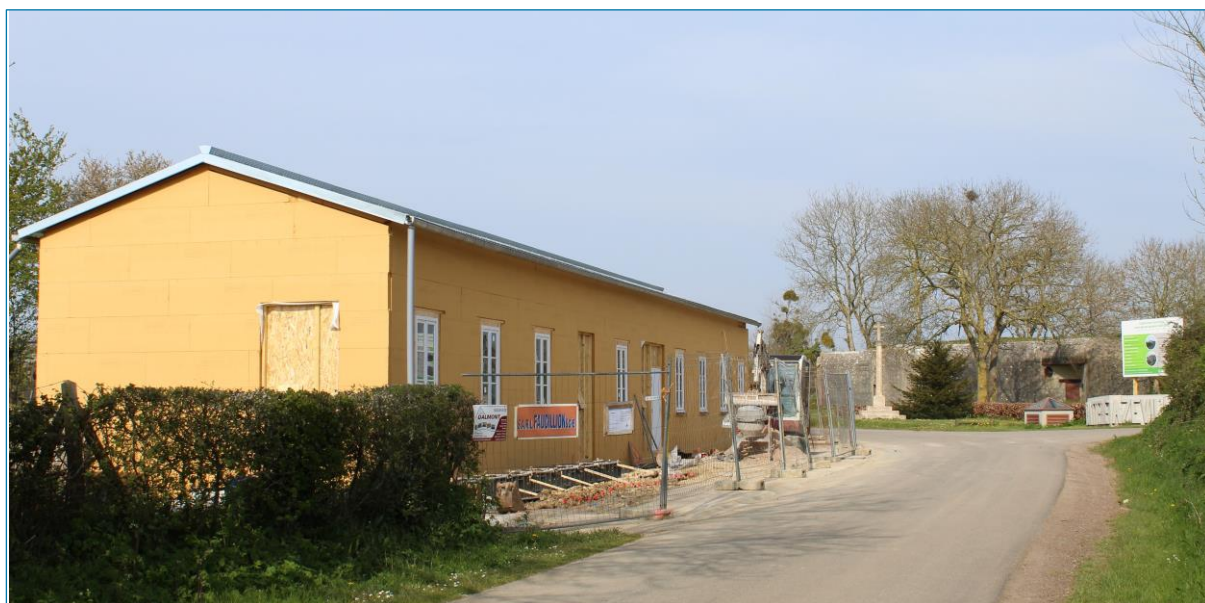
Le « mess » en cours de construction (cliché d'avril 2019).
