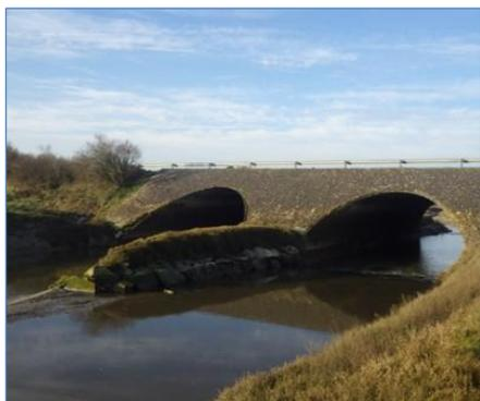
Les travaux consistent à remplacer les deux grandes buses sous la RD 650 dans le Havre de Port-Bail-sur-Mer par un pont dalle de 55 m de long.
