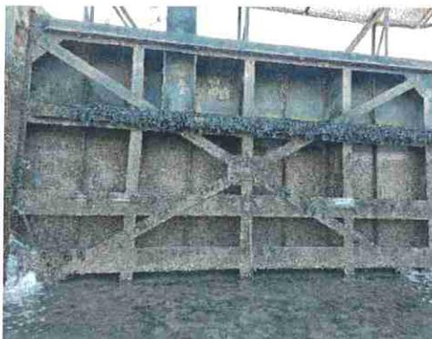
=> Cependant, **les vantaux ne montrent pas de signes d'une nécessité d'un carénage à court ou moyen terme.**
