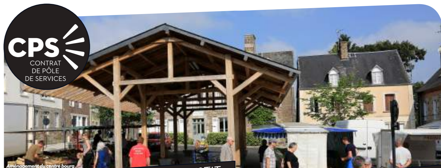
Aménagement du centre bourg
