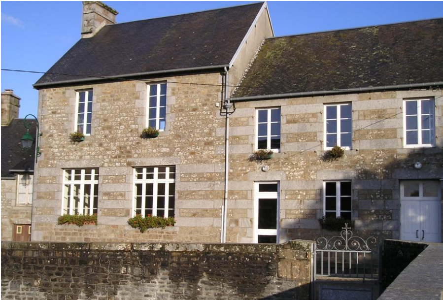
Détail remarquable de l'appareillage de l'ancienne école
