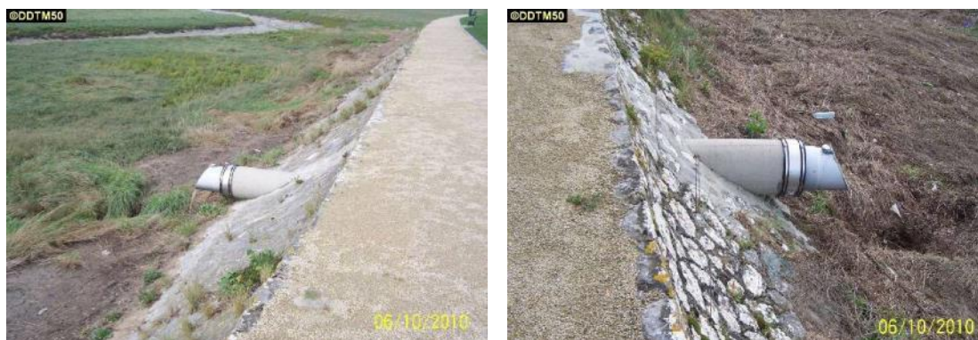
Figure 55 : Émissaires pluviaux débouchant dans le havre de Regnéville (Clichés de la DDTM50)
