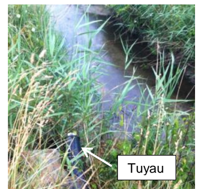
Figure 69 : Tuyau d'évacuation vers le Passevin au niveau des PRL des Minquiers et des Joncquets (CD50)
