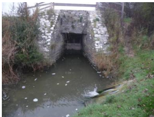
Figure 23 : Vue sur la porte à flot du Canal du Passevin (24/11/2011)
