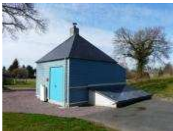
La chaudière collective bois du lotissement de St Samson de Bonfossé (crédit photo Martine Cartier)
